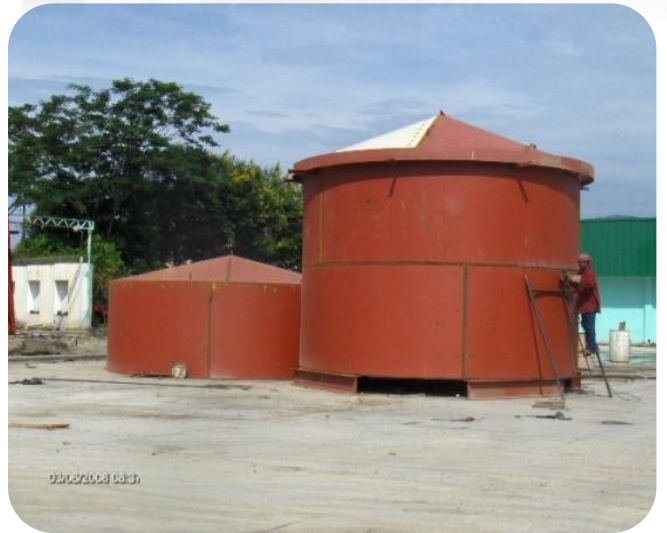
Fabricación y Montaje de Tanques en Parque Industrial Green Valley Envasa.
