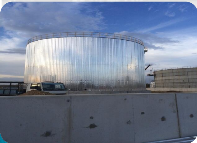
Fabricación y Montaje de Tanque de HN en RKH (Inmsa Argo) Green Valley
