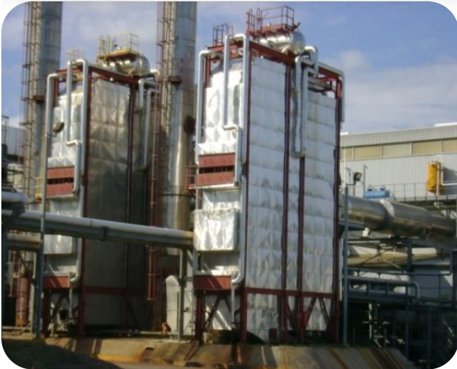
Instalación de sopladores de Vapor en Calderas e Insulación Planta Térmica Enersa Cogeneración.
