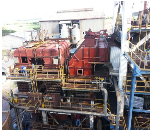
Montaje De Caldera Isgec y Reparación de Caldera HPB, Ingenio Tres Valles – Honduras
